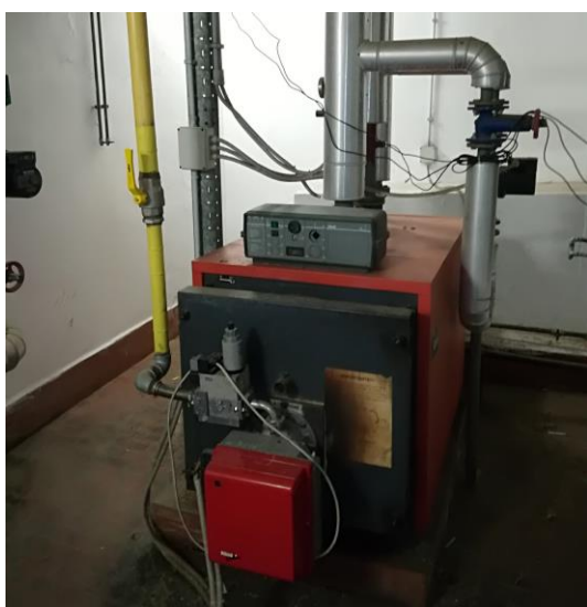
Figura 4.10 - Particolare della caldaia Unical P190
