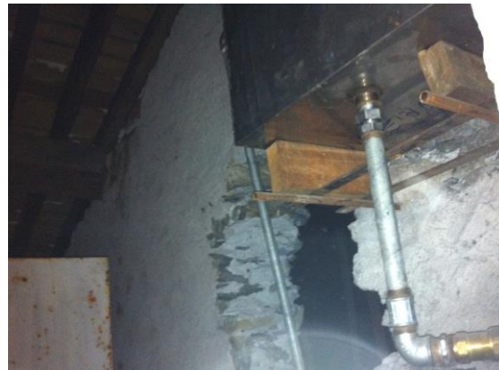
Figura 4.2 - Particolare della muratura in pietra nel sottotetto dell'edificio
