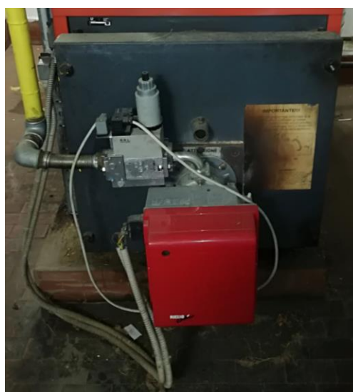
Figura 4.11 - Particolare del bruciatore R.B.L Gulliver BS4D
