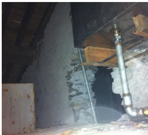
Figura 8.3 – Particolare del sottotetto
