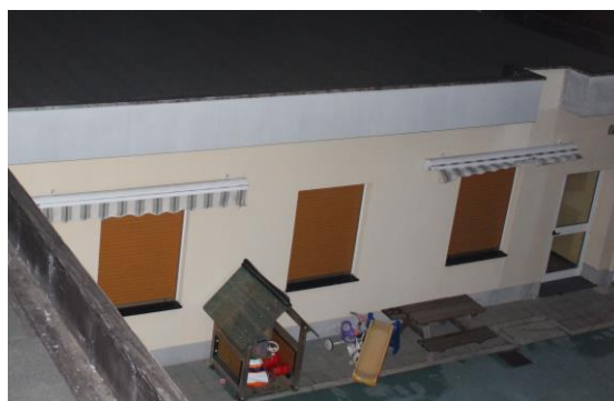
Figura 8.1 - Particolare della facciata interno cortile
