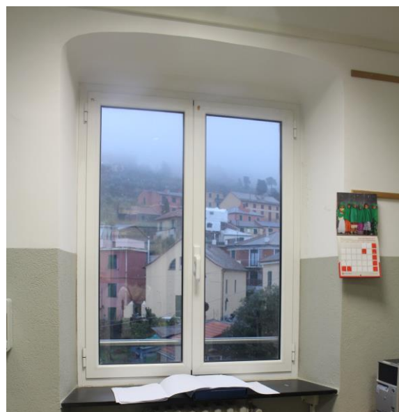
Figura 4.4 - Particolare dei serramenti
