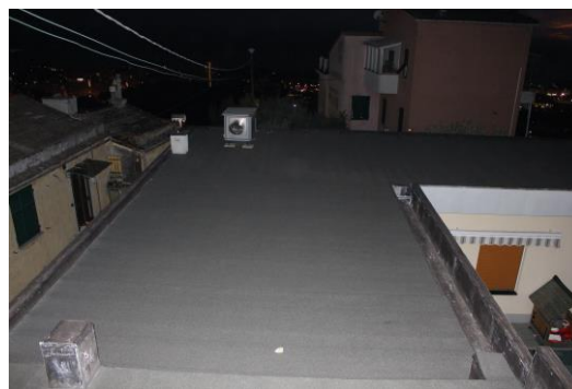
Figura 8.5 - Particolare della copertura
